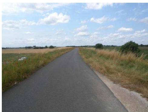
Figure 6 : Vue de la crête de digue
