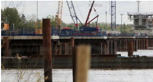
Photographie 1 : Exemple d'estacade - chantier LGV Bordeaux
